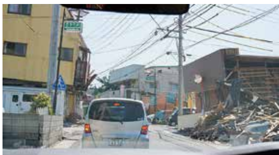
4月30日 熊本県益城町傾く街並み、屋内避難などできない
